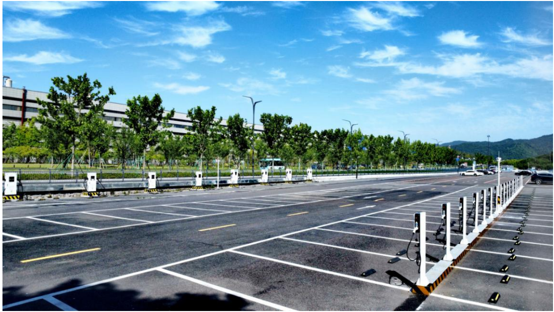
宁波市鄞州区瞻岐镇充电基础设施“村镇统筹”推进项目
